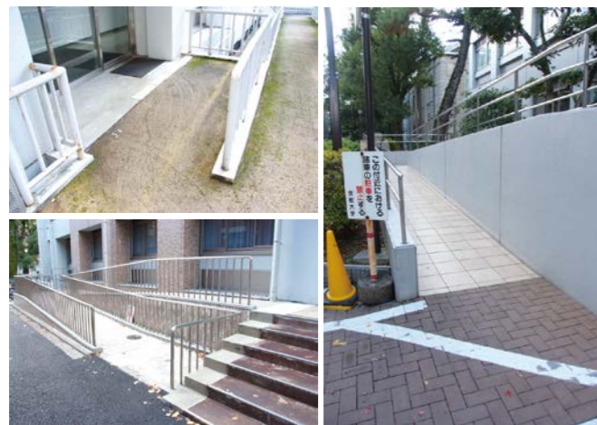
△コンクリートで囲われ、多少圧迫感がある事例。 △斜度と経路長はトレードオフで、傾斜を緩やかにすると面積をとってしまう。
