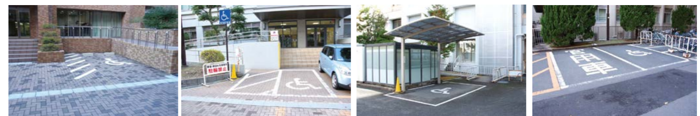
◎スロープ近くに設置されていて、 実際の使い勝手を考慮している 事例。身体障害者用駐車スペースが多数設けられていて、ドアを全開するためのスペースもしっかり確保、配慮がなされている。 ◎雨よけのカーポートの設置例。スロープも隣接している。ただし、屋根がもう少し大きい方が望ましい。 △場所を入れ替えたほうが、ドアを開くスペースを確保できる。
