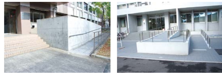
△コンクリートで囲われ、多少圧迫感がある事例。 △斜度と経路長はトレードオフで、傾斜を緩やかにすると面積をとってしまう。
